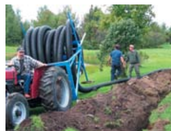
Поставка на место выполнения работ в соответствии с заказом; монтаж непосредственно из бухты
